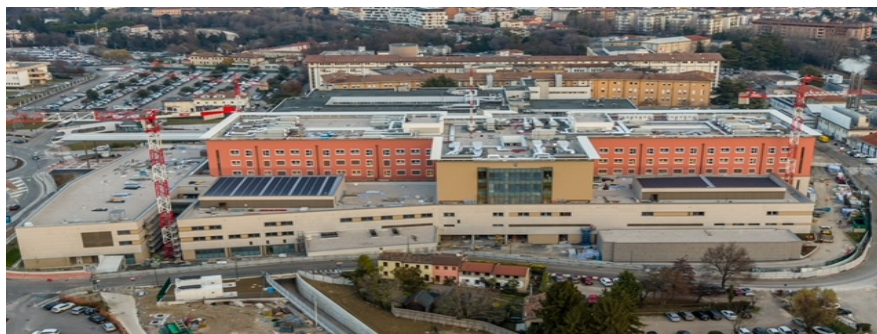
Foto: Cittadella di Treviso in costruzione
