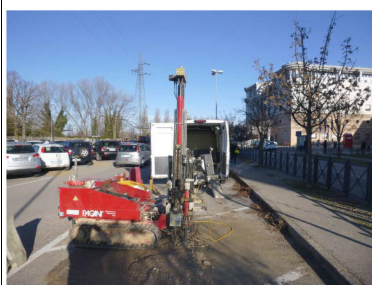
Esecuzione della prova CPTU1
