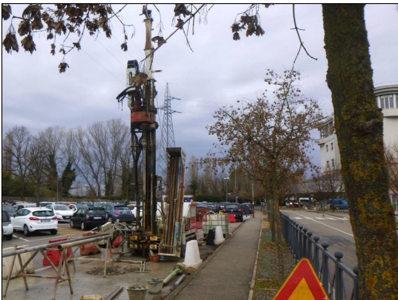
Posizionamento Sondaggio Geognostico S1
