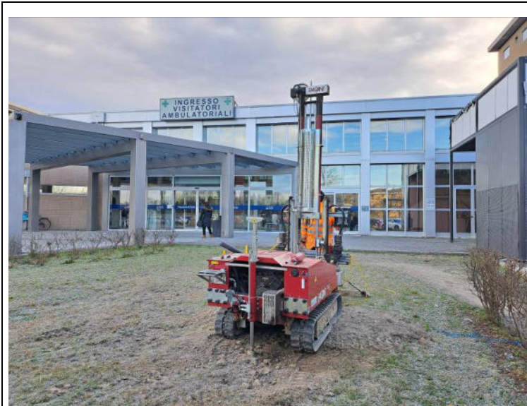
Esecuzione della prova SCPTU3
