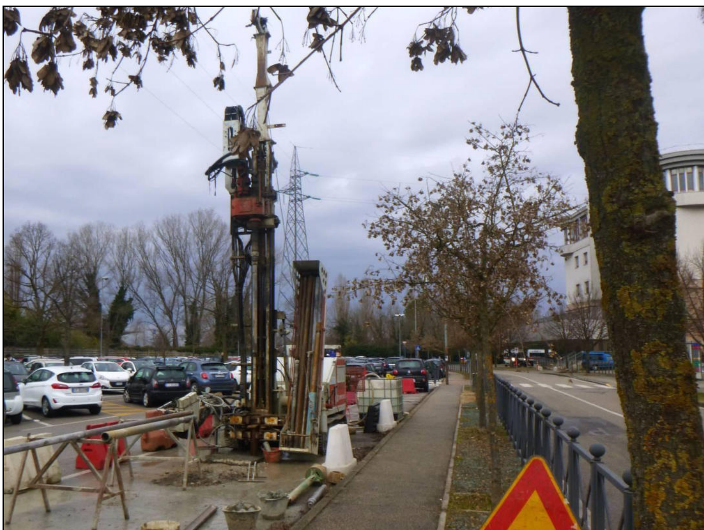
Posizionamento Sondaggio Geognostico S1
