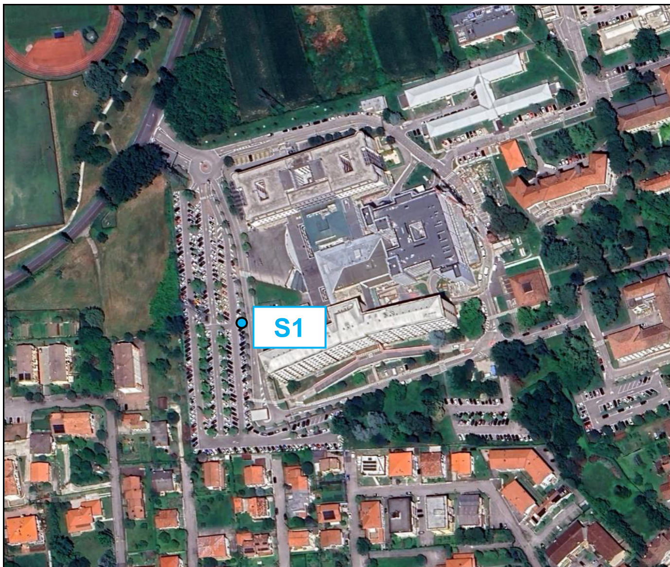
Ubicazione Sondaggio Geognostico S1
